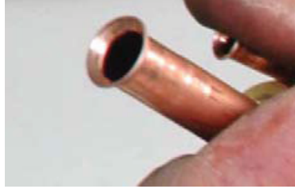
Figure 6.11 Flare the end of the tube (D)
